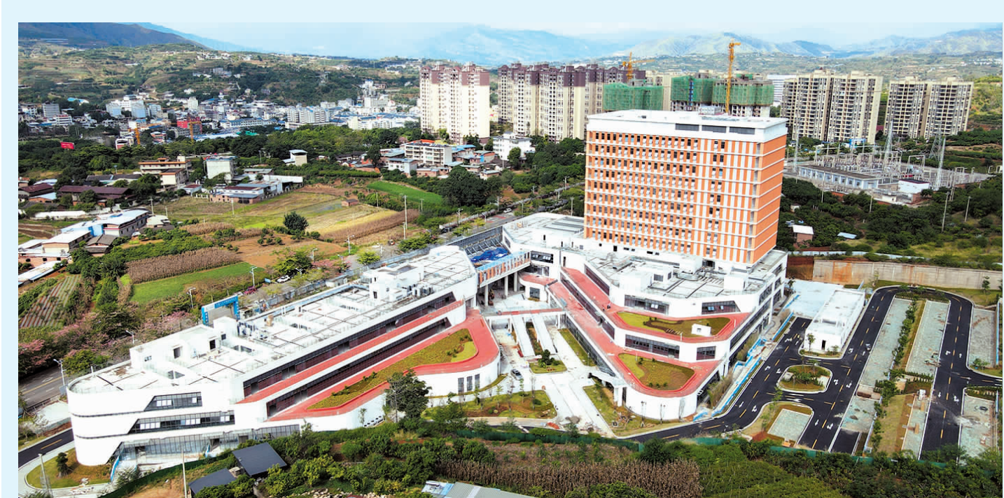
2025 年 12 月 29 日,矿业工程公司承建的盐边县第二人民医院建设工程项目全面完工。(秦小彬 摄)
