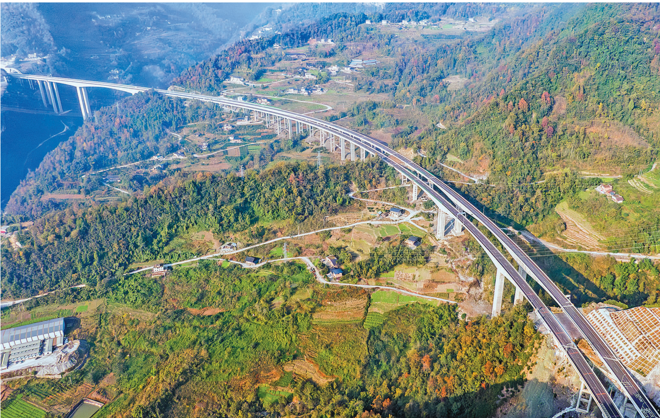
渝湘复线高速公路石桥特大桥等桥梁工程 (彭著陈 摄)
