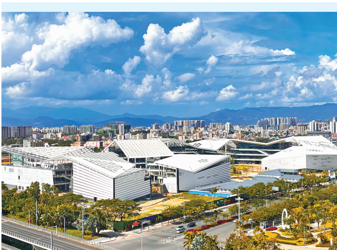
广西公司承建的陵水“五馆”一中心项目 (陆鑫昊 摄)
