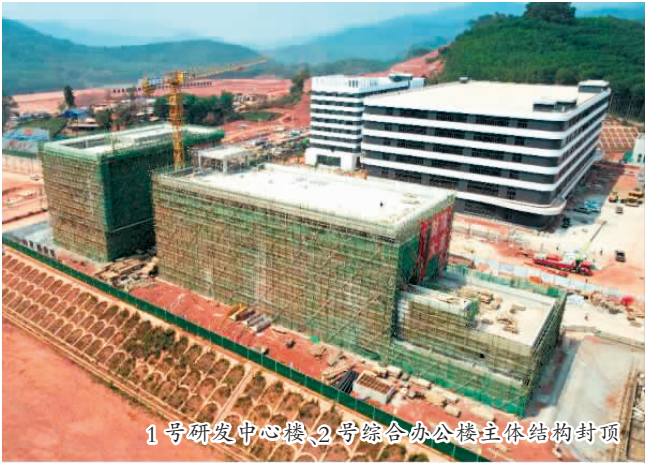
1号研发中心楼主体结构封顶
