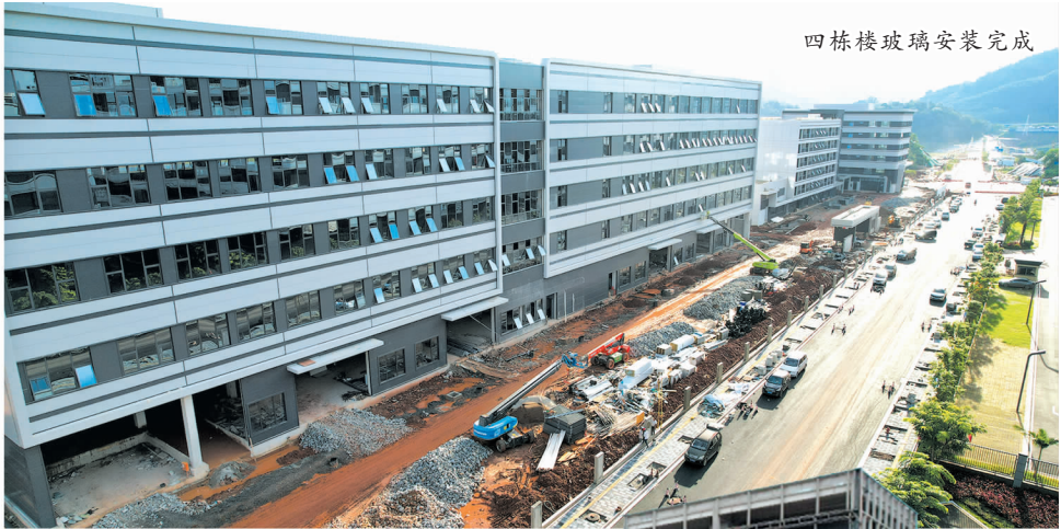
3号、4号钢结构的厂房楼外幕墙安装完成
