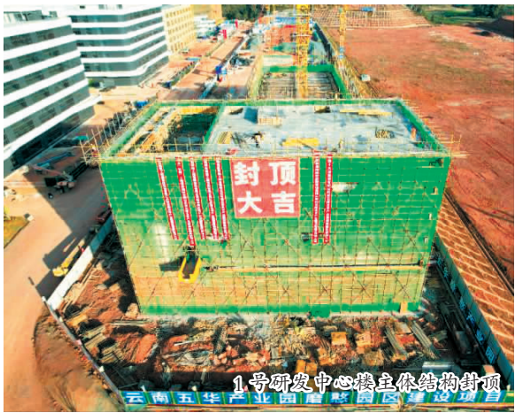
主体结构施工
