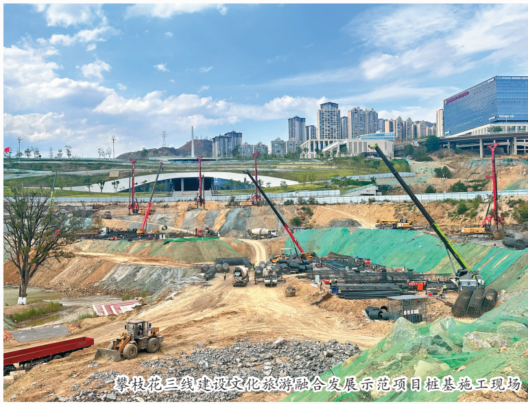
攀枝花三线建设文化旅游融合发展示范项目桩基施工现场
