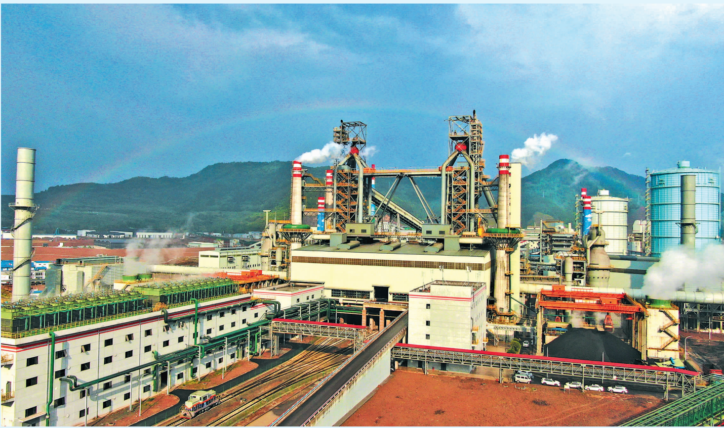
中国十九冶承建的达钢搬迁升级改造项目 1 号 2 号高炉 (陈星宇 摄)
