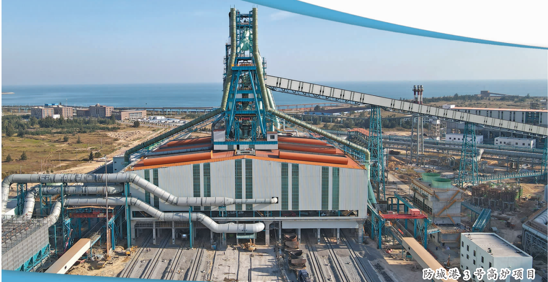
防城港 3 号高炉项目
